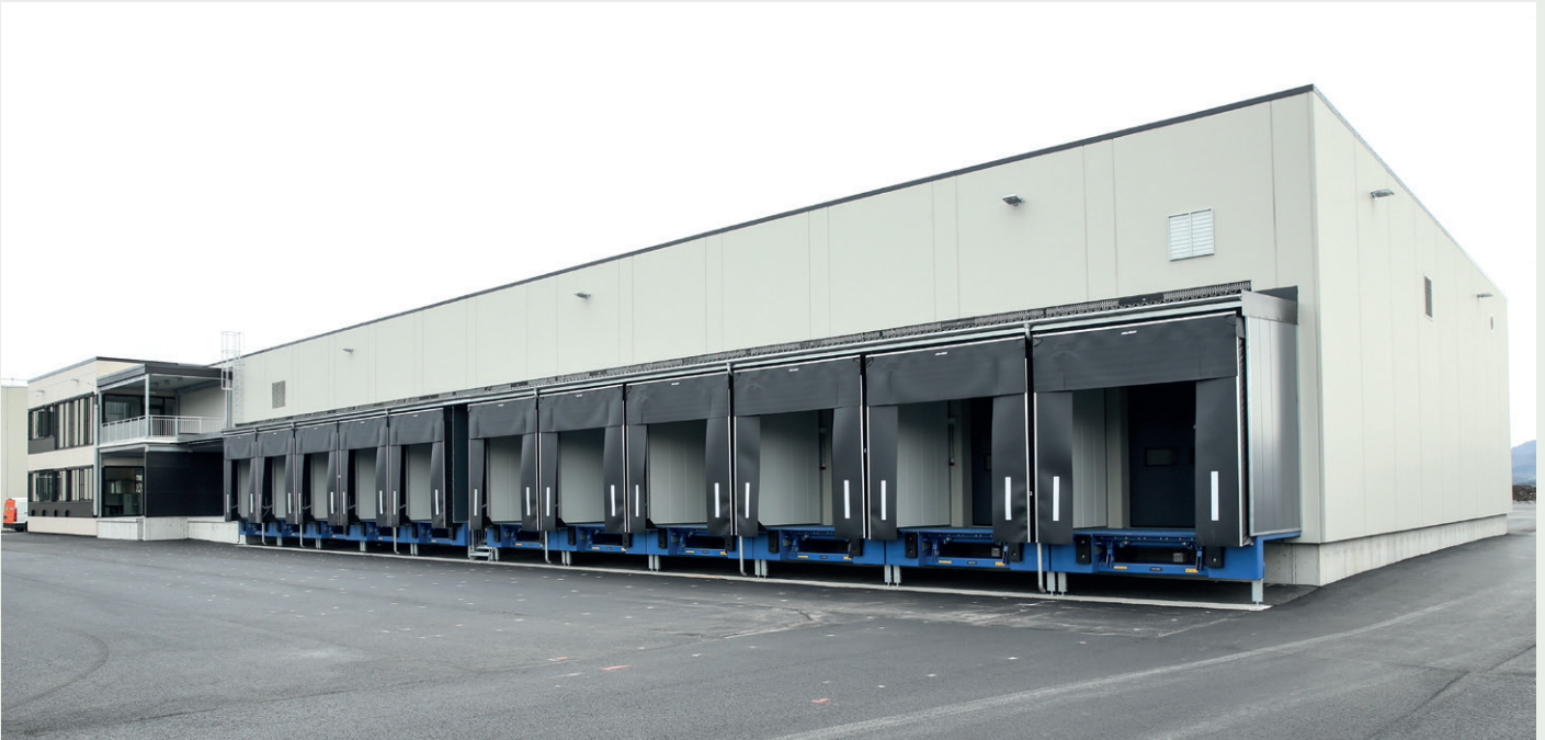
Fra fronten av bygget med lasteramper inn til omlastingsterminalen, og kontorbygget bortenfor.
