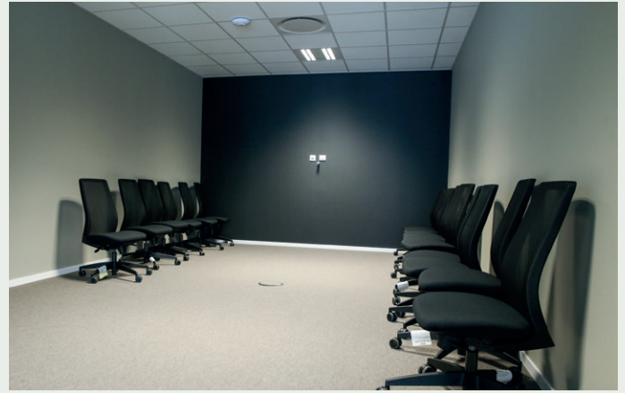
Møterommet i andre etasje har teppeflis på gulv, sparklet og malt gips på vegger og systemhimling.
